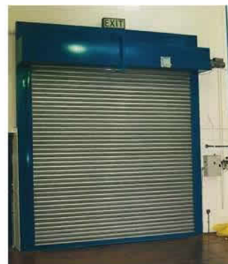
Roller shutter fire door
